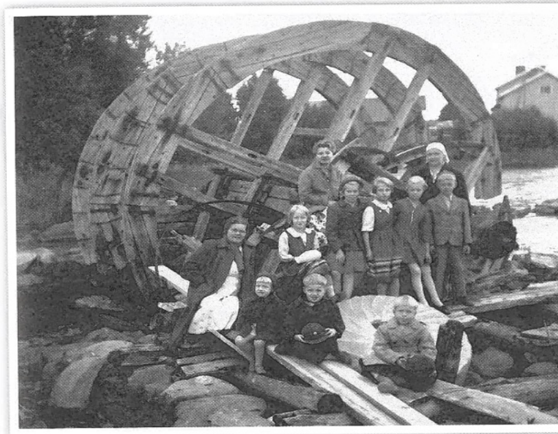
Jälkipolvea Antti Itkosen 1910-luvulla rakentaman myllyn raunioilla Leppävirran Naaponkoskella. Kuva on vuodelta 1955.
